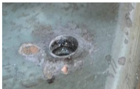
图 1 A 相压顶的短接片螺杆固定点周围涂有较厚的绝缘漆
