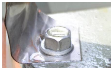
图 2 短接片与压顶间接触不够紧密
