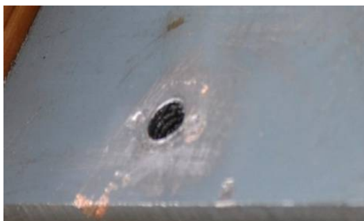
图 4 对压顶表面短接片固定处进行除漆处理
